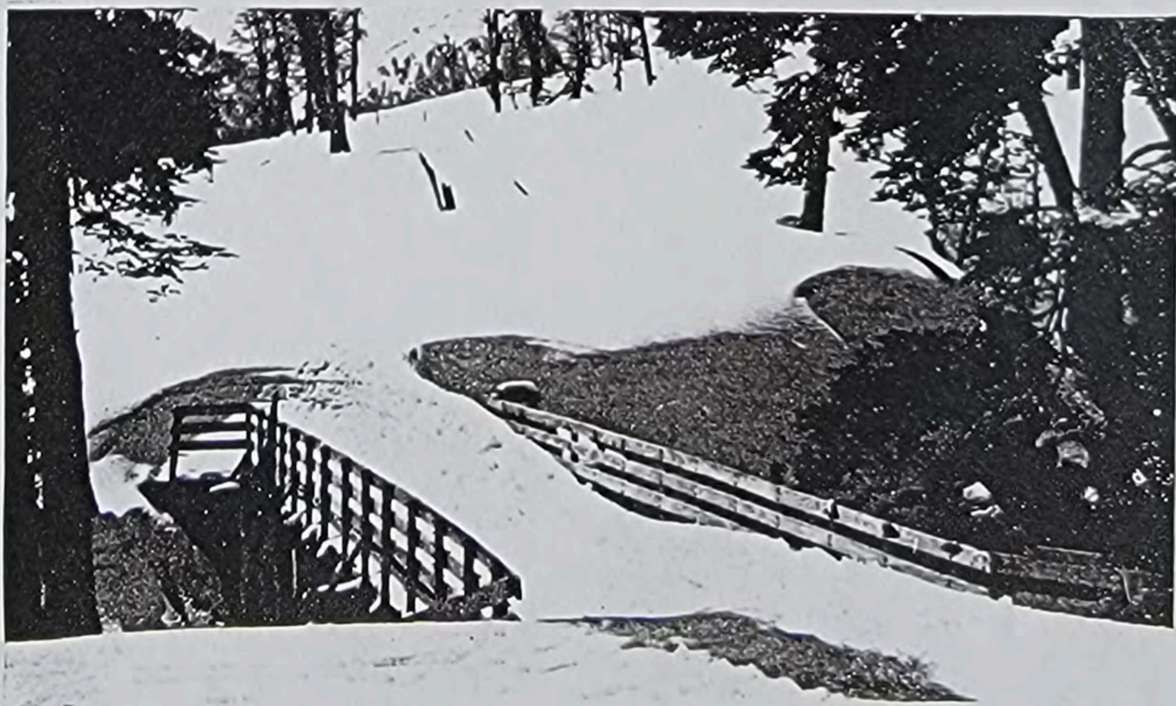
Un pont sur la route des Thermes
